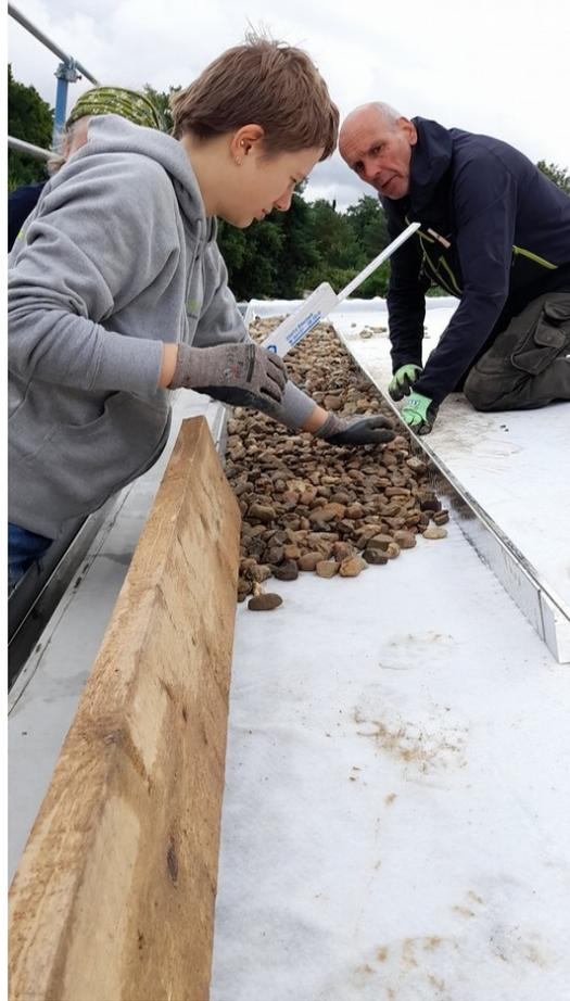
**Das Substrat** haben wir fertig gemischt, lose in BibBags gekauft. Das wurde dann in der gleichen Weise wie der Kies aufs Dach gebracht und in einer Schicht von 8 cm Höhe verteilt. Das Substrat setzt sich und wird dann etwa die Höhe von 7 cm haben. Leicht düngen mit einem organischen Dünger.
